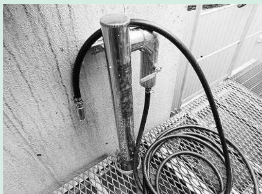
消火用水栓（4箇所増設）
