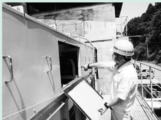
コンベア点検口（8箇所増設）
