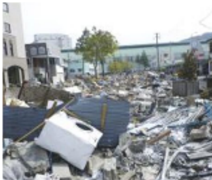
2011.4 津波被害の直後
