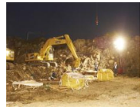
2011.12 夜間作業の様子 (宮城県石巻市)
