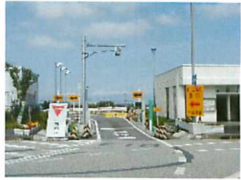
入善スマートIC（工事前）
